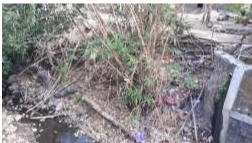
Gambar 9. Kondisi Kali Giriloyo Sumber: Observasi lapangan, 2020
