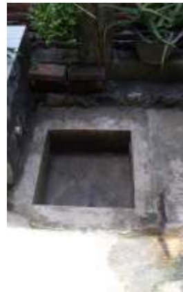
Gambar 10. Bak penampungan limbah cair batik sebelum disalurkan ke sumur Sumber: Observasi lapangan, 2020
