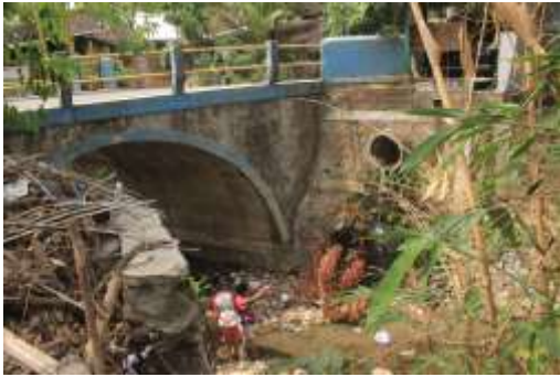
Gambar 8. Kondisi Kali Giriloyo Sumber: Observasi lapangan, 2020
