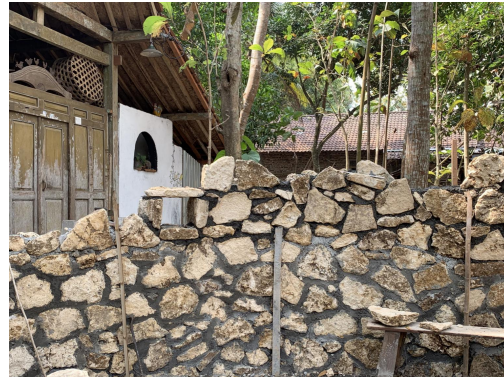
Gambar 6. Batu kapur/ sand stone sebagai material lokal yang digunakan dalam karya Eko Prawoto
