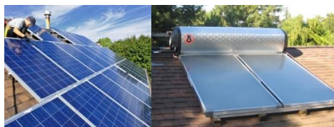
Gambar 4. Pemasangan solar panel dan solar water heater
