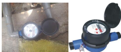
Gambar 5. Pemasangan meteran air
