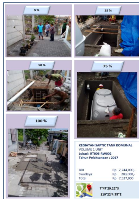
Gambar 8. Kegiatan pembangunan septic tank komunal di wilayah Kelurahan Suryatmajan
