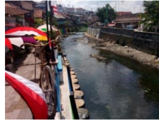
Gambar 4. Talud penahan banjir Sumber: Dokumentasi penulis, 2019
