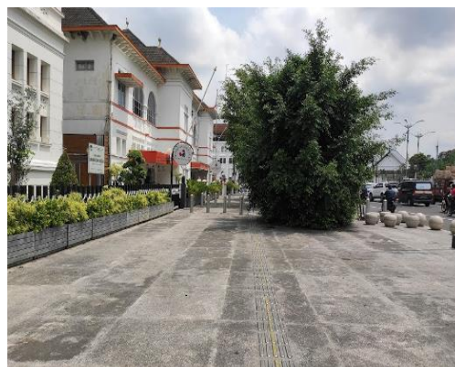
Gambar 14. Kondisi jalur pejalan kaki di kawasan Nol Km Yogyakarta di ujung Jl. Panembahan Senopati
