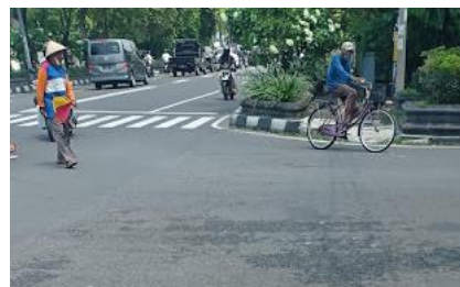
Gambar 5. Fasilitas penyeberangan di simpang Kebun Binatang Gembira Loka yang tidak lengkap di salah satu sisinya
