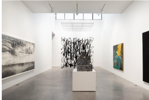
Gambar 11. Jendela clerestory yang digunakan untuk memasukkan cahaya ke dalam ruang galeri
