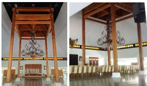
Gambar 6. Sistem struktur Joglo empat saka guru pada pendopo Sabha Swagata Blambangan
