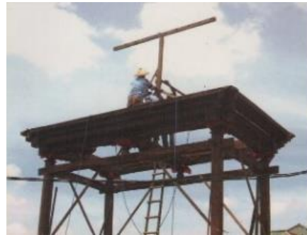
Gambar 7. Pemasangan struktur atap Joglo
