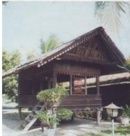
**Gambar 10. Pintu pada *Rumoh Aceh* terhubung dengan tangga yang terletak di samping rumah dan di bawah rumah**
