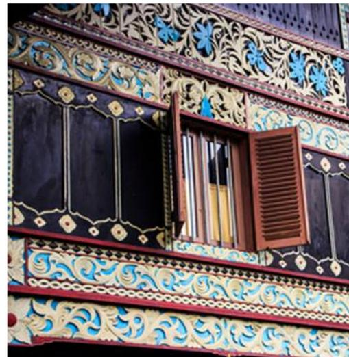
**Gambar 9. Bukaan/jendela di semua sisi dan ditambahkan dengan ventilasi yang berbentuk ornamen atau ukiran yang dilubangi sehingga udara dan cahaya tetap masuk**
