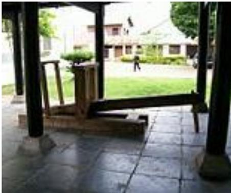
**Gambar 5. Batu pondasi (kiri) dan pondasi beton (kanan) untuk menghindari kayu dan kelembapan tanah**
