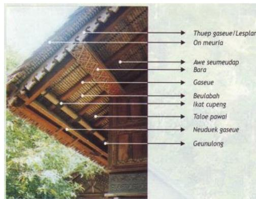
**Gambar 7. Struktur atap yang mempergunakan material kayu untuk usung dan reng serta daun Rumbia sebagai penutup atap**
