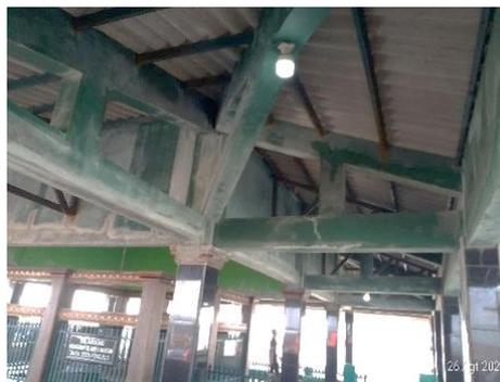
**Gambar 8. Konstruksi kolom, balok, dan setengah kuda-kuda**
