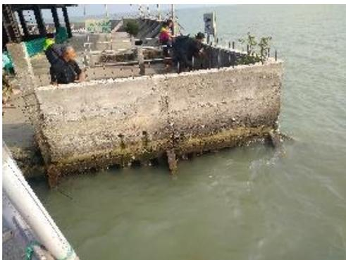
**Gambar 10. *Bracing*/penguat dinding dan pondasi perluasan**
