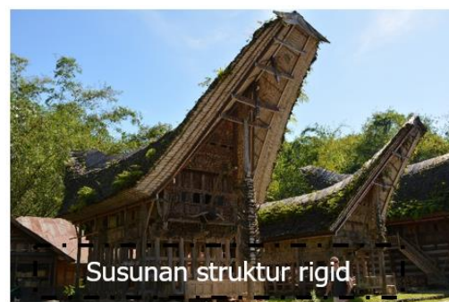
Gambar 14. Susunan kolom & pondasi umpak rumah Tongkonan
