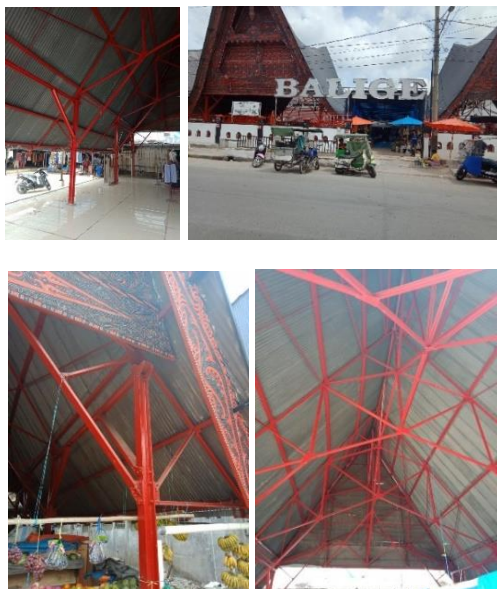
Gambar 11. Perlakuan pembentukan struktur bangunan dua dimensi pada sistem struktur yang didesain untuk tiga dimensi Sumber: Dokumentasi penulis, 2023
