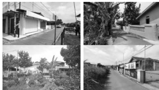
Gambar 7. Kondisi bangunan Kelurahan Labuhan Ratu
