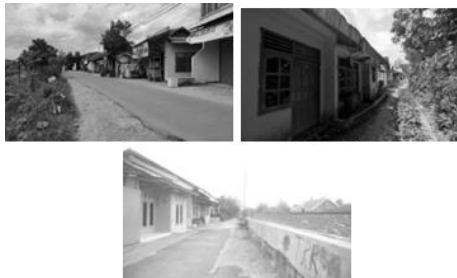
Gambar 10. Kondisi jalan Kelurahan Kampung Baru
