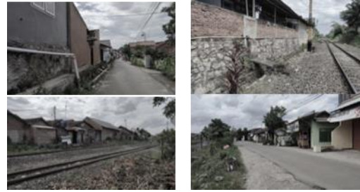
Gambar 3. Kondisi bangunan Kelurahan Kampung Baru
