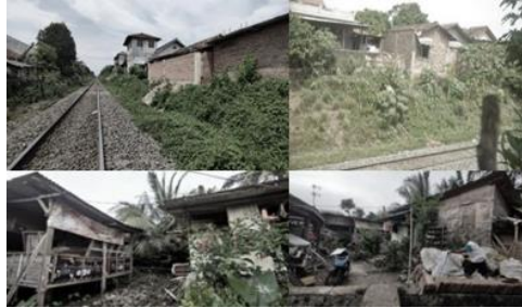
Gambar 5. Kondisi bangunan Kelurahan Labuhan Ratu Raya
