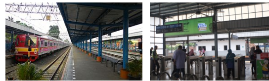
Gambar 4. Kondisi peron dan Stasiun Tangerang Sumber: Dokumentasi pribadi, 2019
