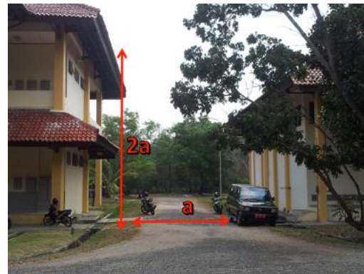
Gambar 10. Foto rasio ketinggian bangunan dan lebar jalan pada Fakultas Teknik Unsri Sumber: Observasi, 2014
