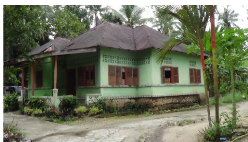
Gambar 11. Rumah setelah perubahan kampung
