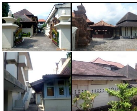
Gambar 12. Jarak antar bangunan yang terlalu dekat
