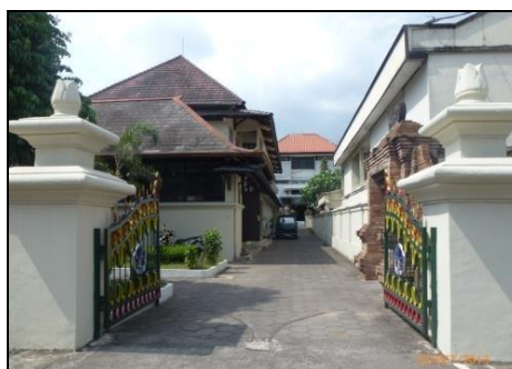
Gambar 7. Ruang antar bangunan sempit dan kurang nyaman.
