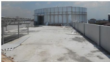
Gambar 8. Atap dak pada sisi Selatan
