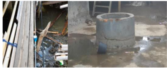
Gambar 6. Kondisi penyediaan air minum di kawasan Wuring
